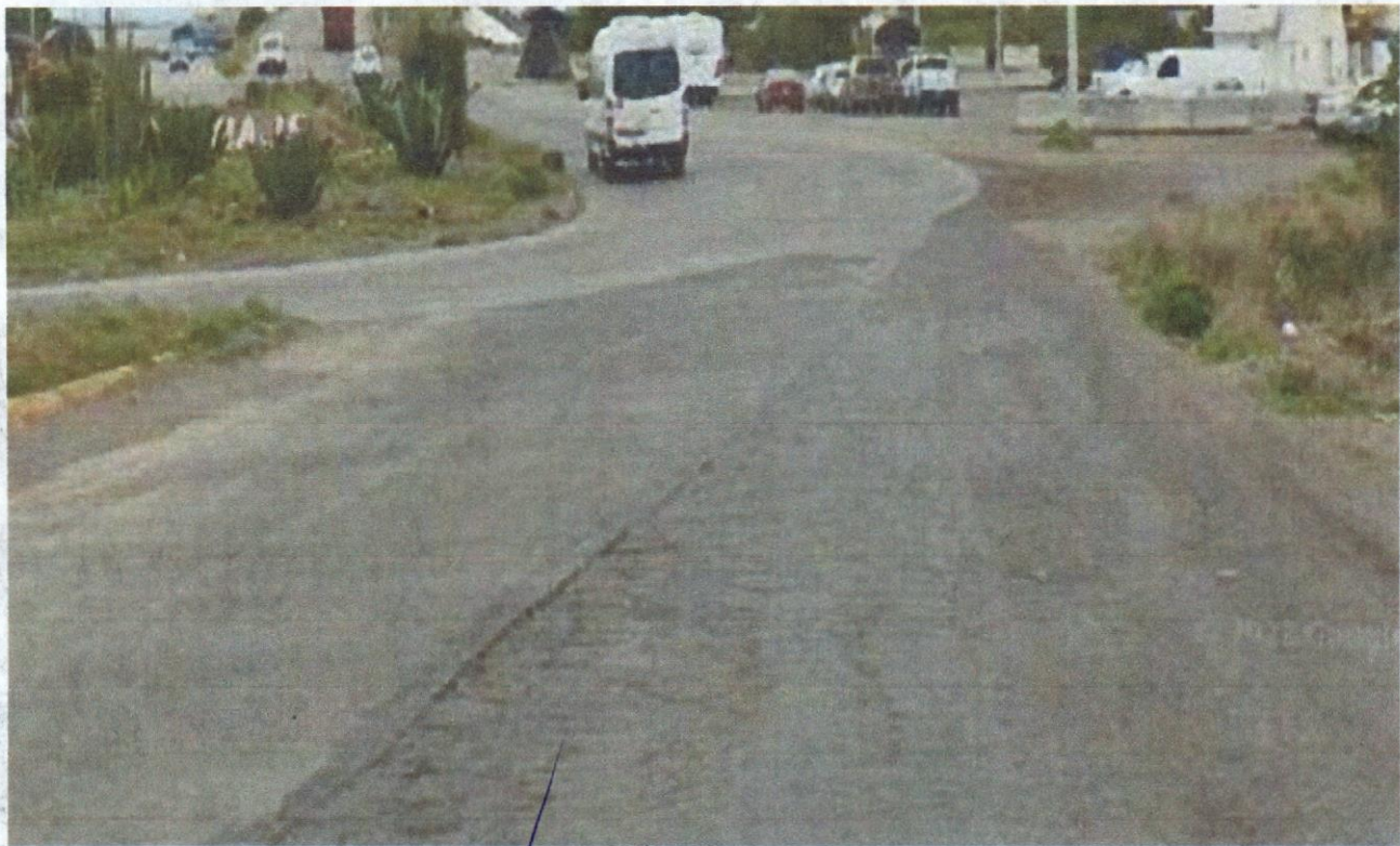
FOTOGRAFÍA 4. Término del camino
